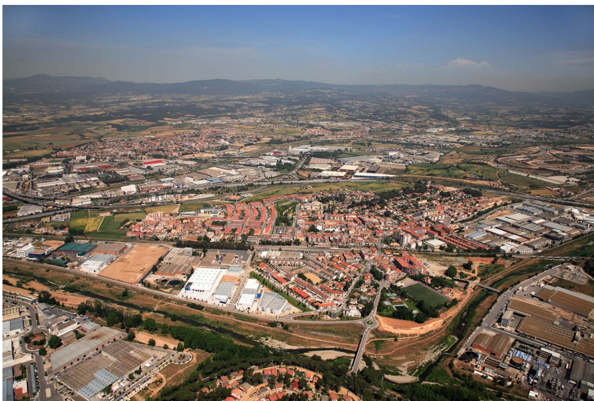
Figura 2.13. Vista aèria del municipi on es poden observar les fractures generades pels eixos de comunicació: línia del ferrocarril i autopista AP-7.
