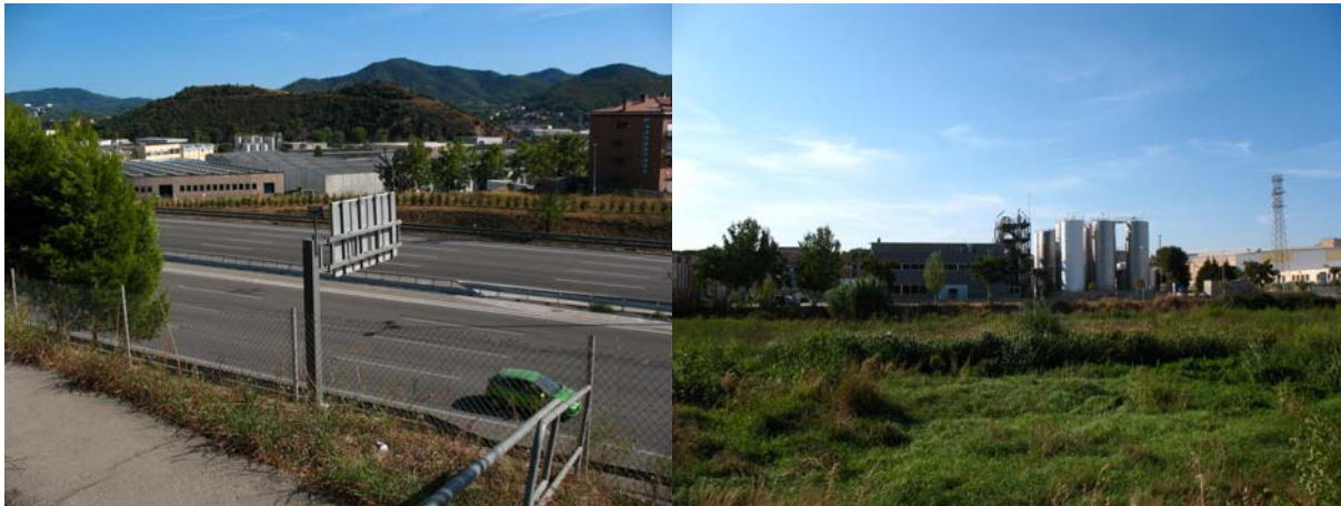
Figura 2.18. Dues vistes del polígon industrial El Pedregar, des del nord de l'AP-7 on es veu la proximitat del teixit residencial i des del riu Congost.
