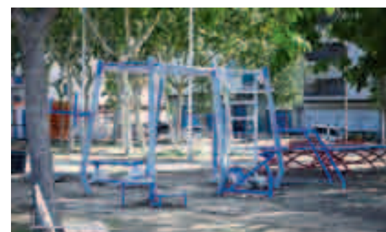
Obras de rehabilitación del parque del Sant Crist
