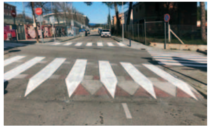
Manteniment senyalització viària
