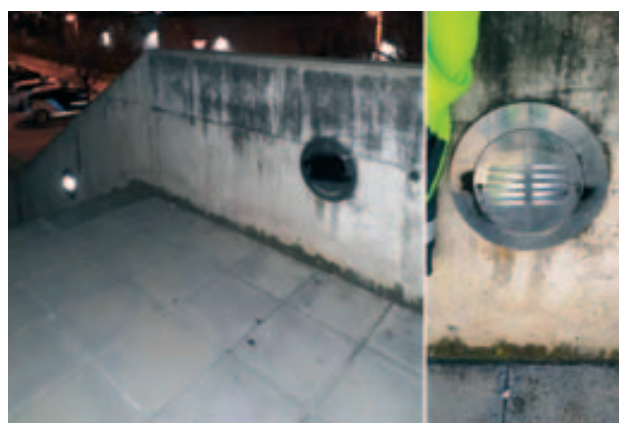
Neteja grafitis i reparació enllumenat (rampa Estació Jove)
